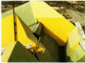
Austragsseite des Tiefbunkers
